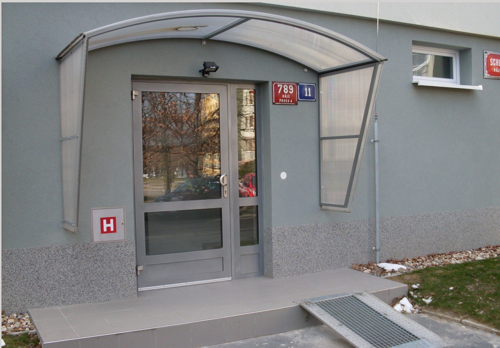
Vstupní portály – nájezdová bezbariérová rampa a nové sokly
