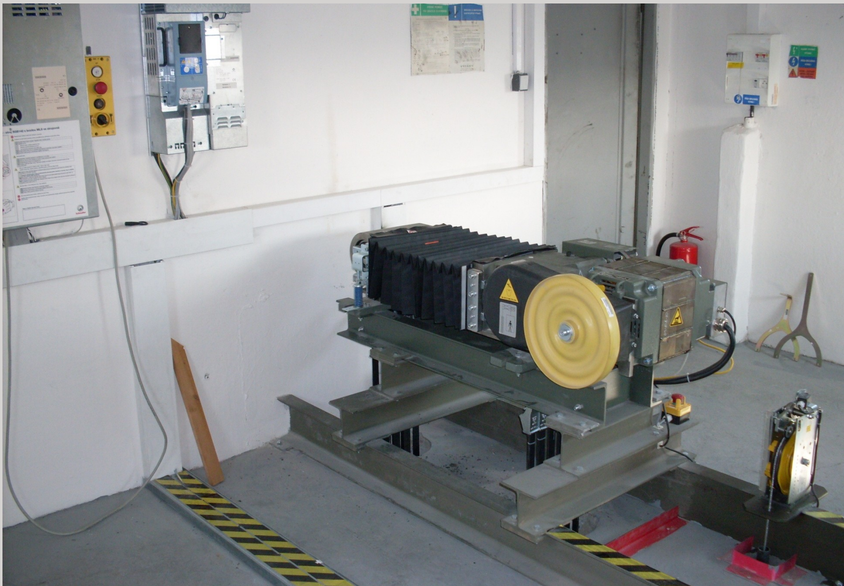
Výtahy – kompletní rekonstrukce strojoven výtahů
