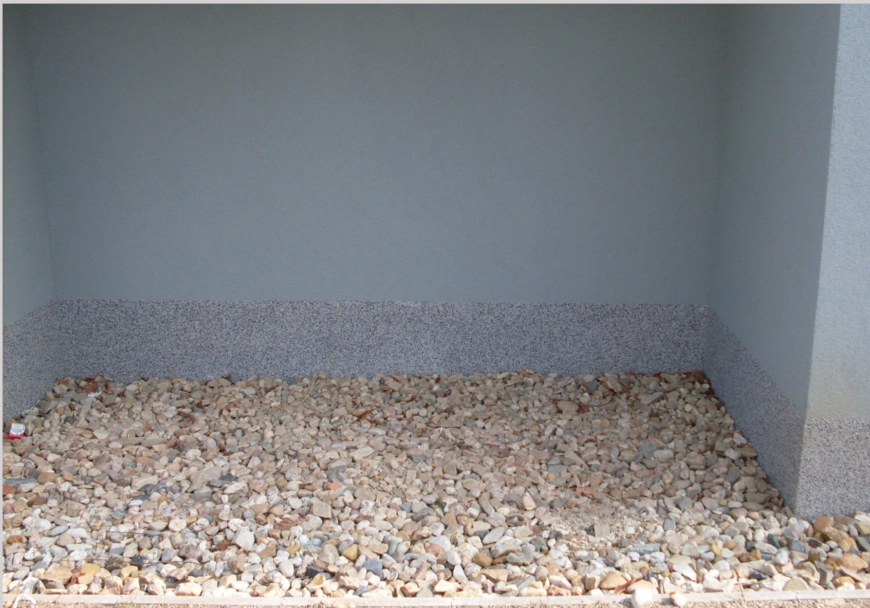
Hydroizolační zakončení paty domu – prostor pod lodžiemi
