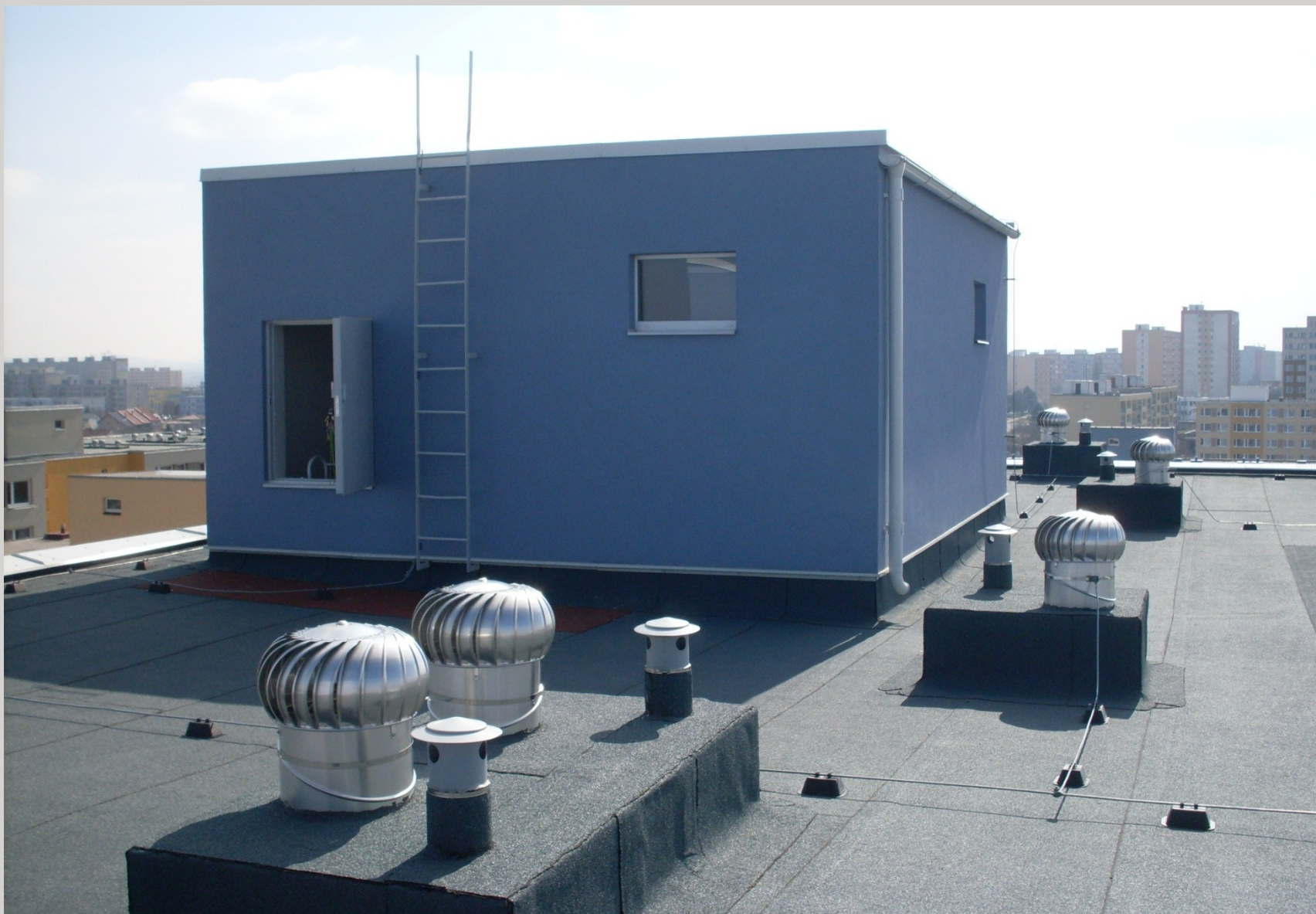
Střecha – nový povrch a zakončení svislých konstrukcí
