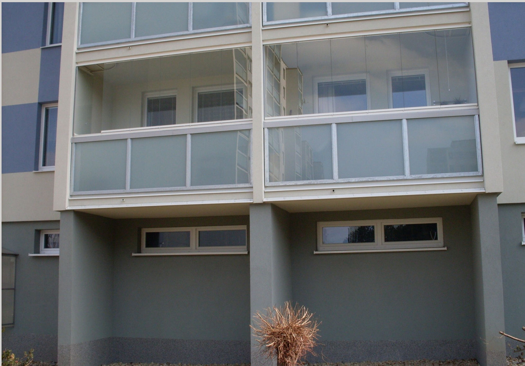
Lodžie – zasklení všech lodžii v celém domě, dořešení okapnic
