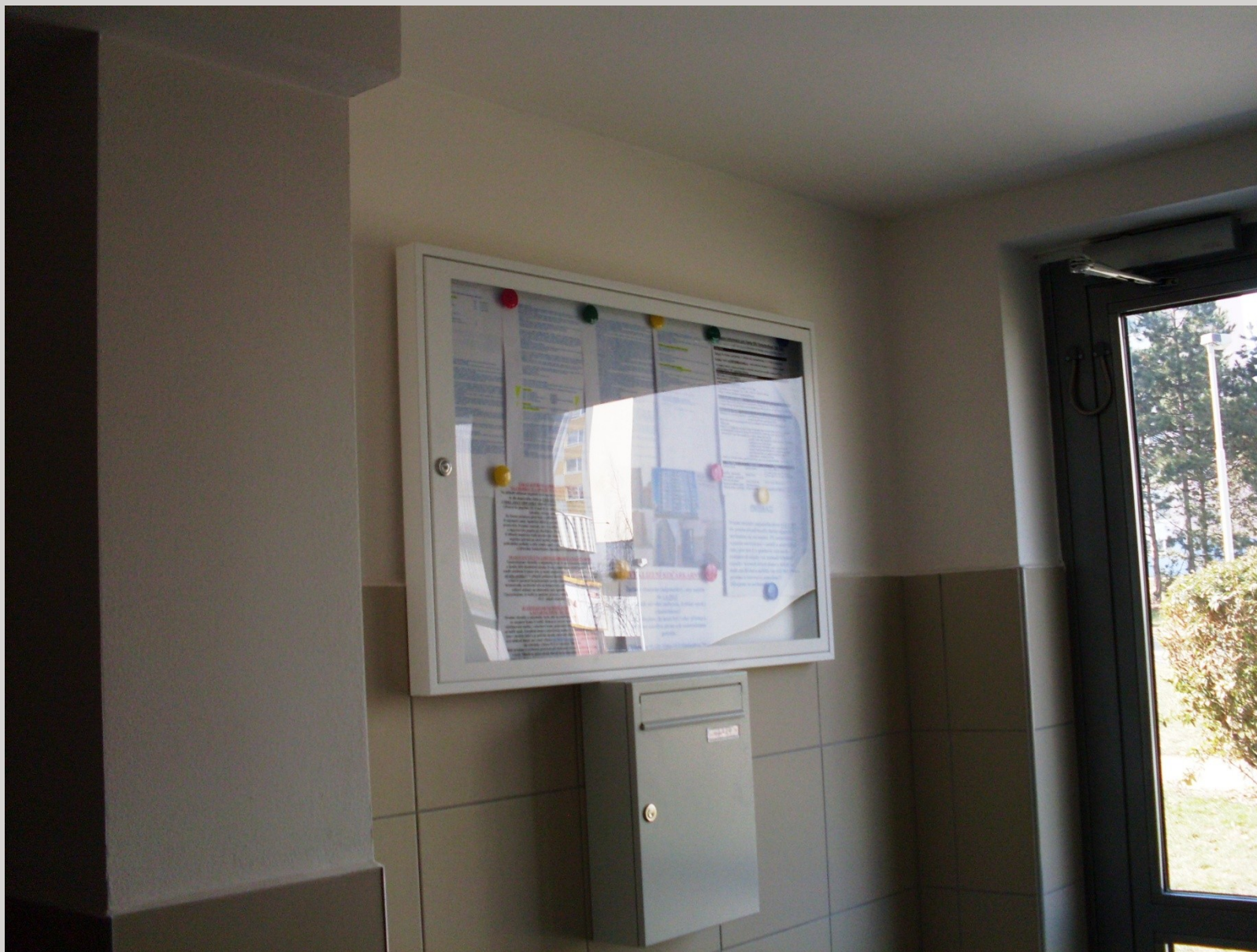
Interiér domu – vstupní prostor s obklady a sádkokartonovými podhledy a přeložkami
