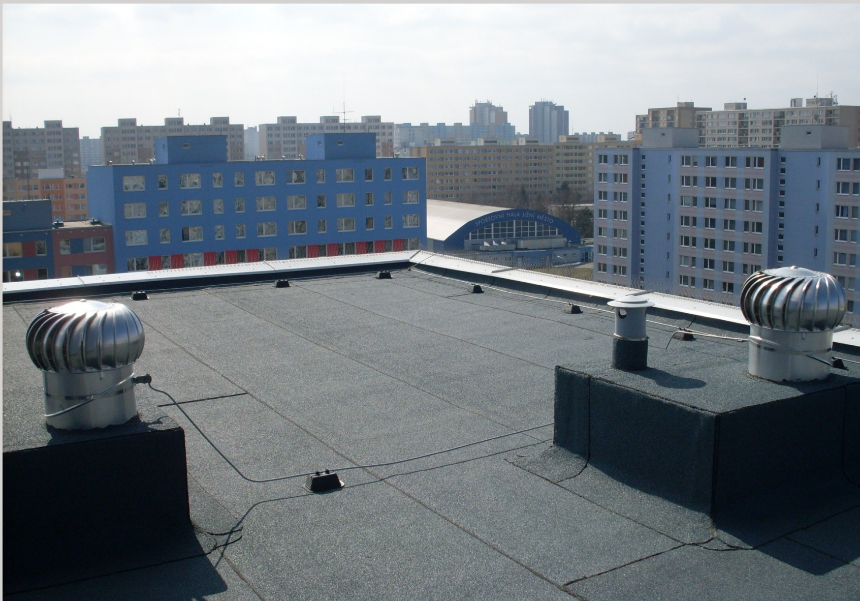
Střecha – nové hromosvody a atiky
