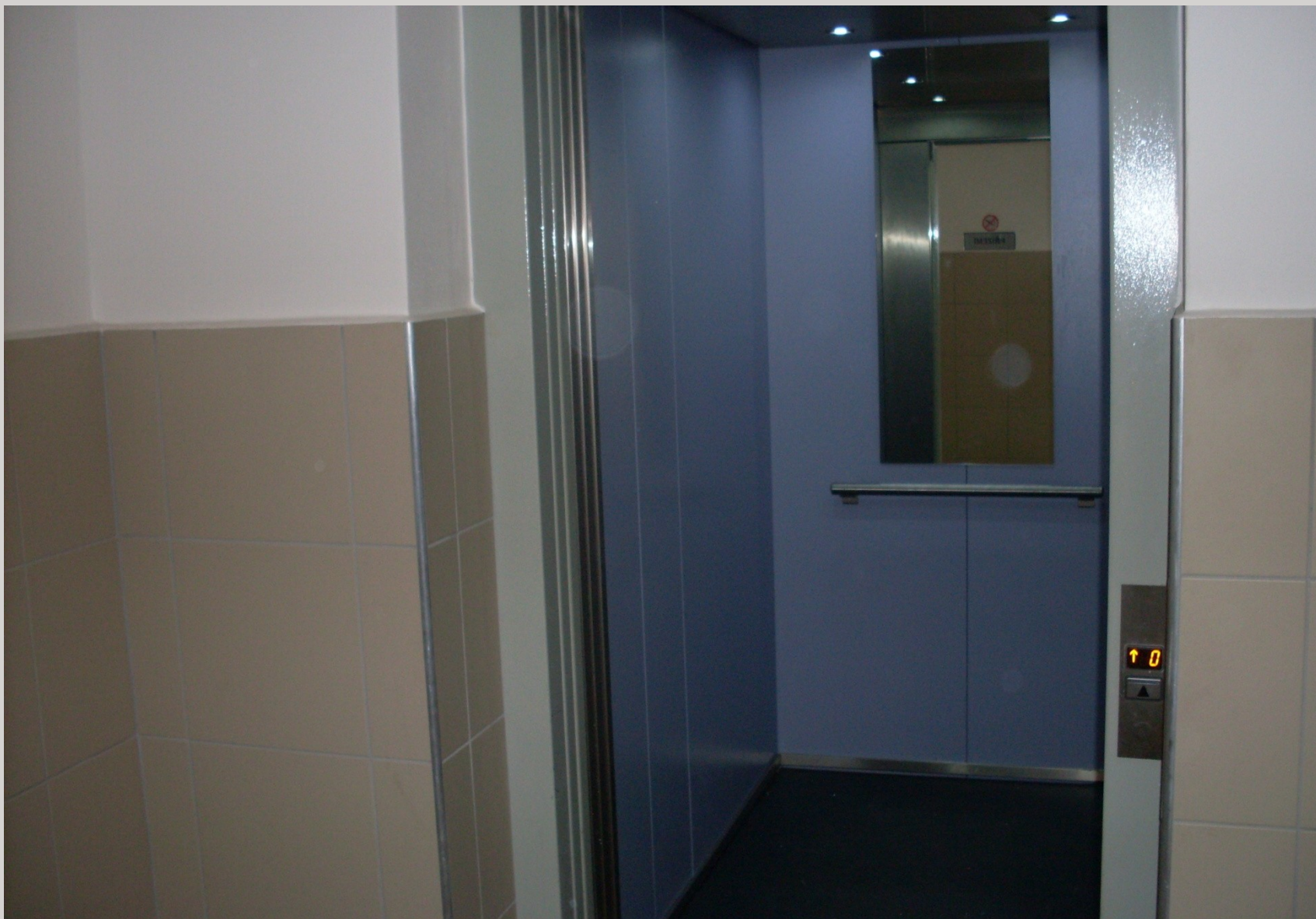
Výtahy – nové výtahové klece
