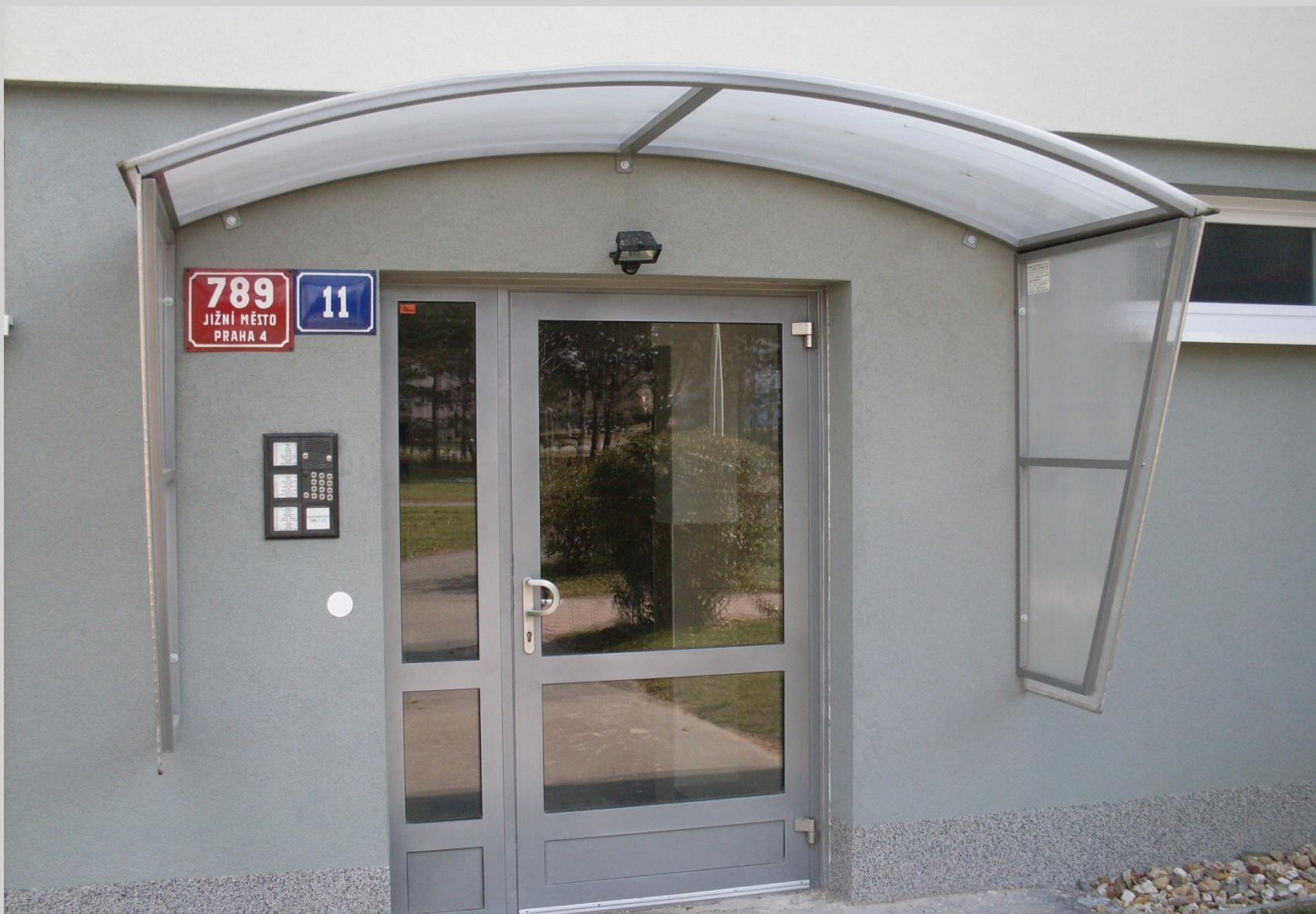
Vstupní portály – nový zvonkový systém s bytovým vrátným
