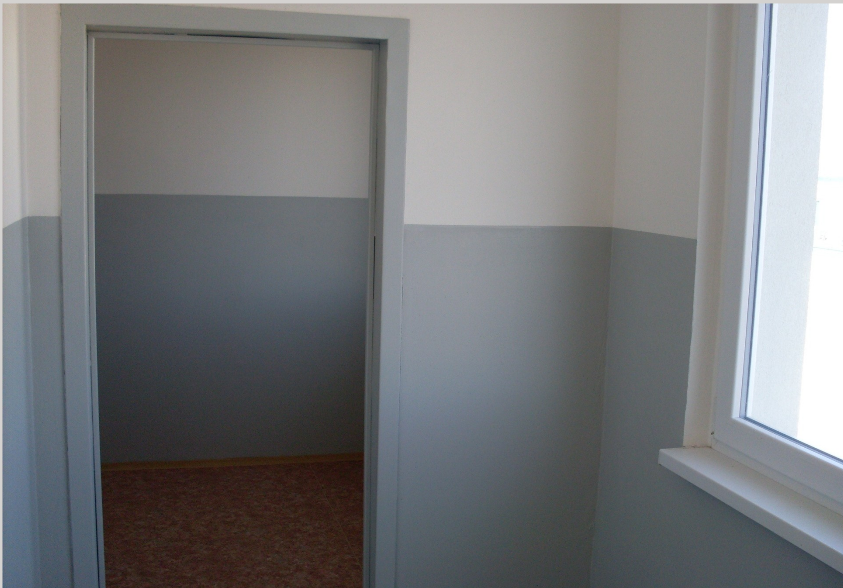
Interiér domu – revitalizace zárubní, pokládka lina, nová okna
