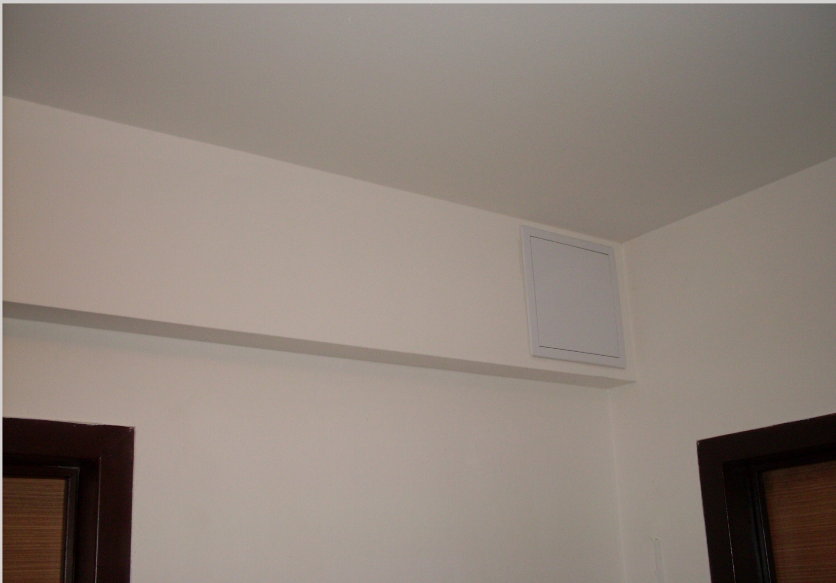
Interiér domu – sádrokartonové obklady elektrorozvodů
