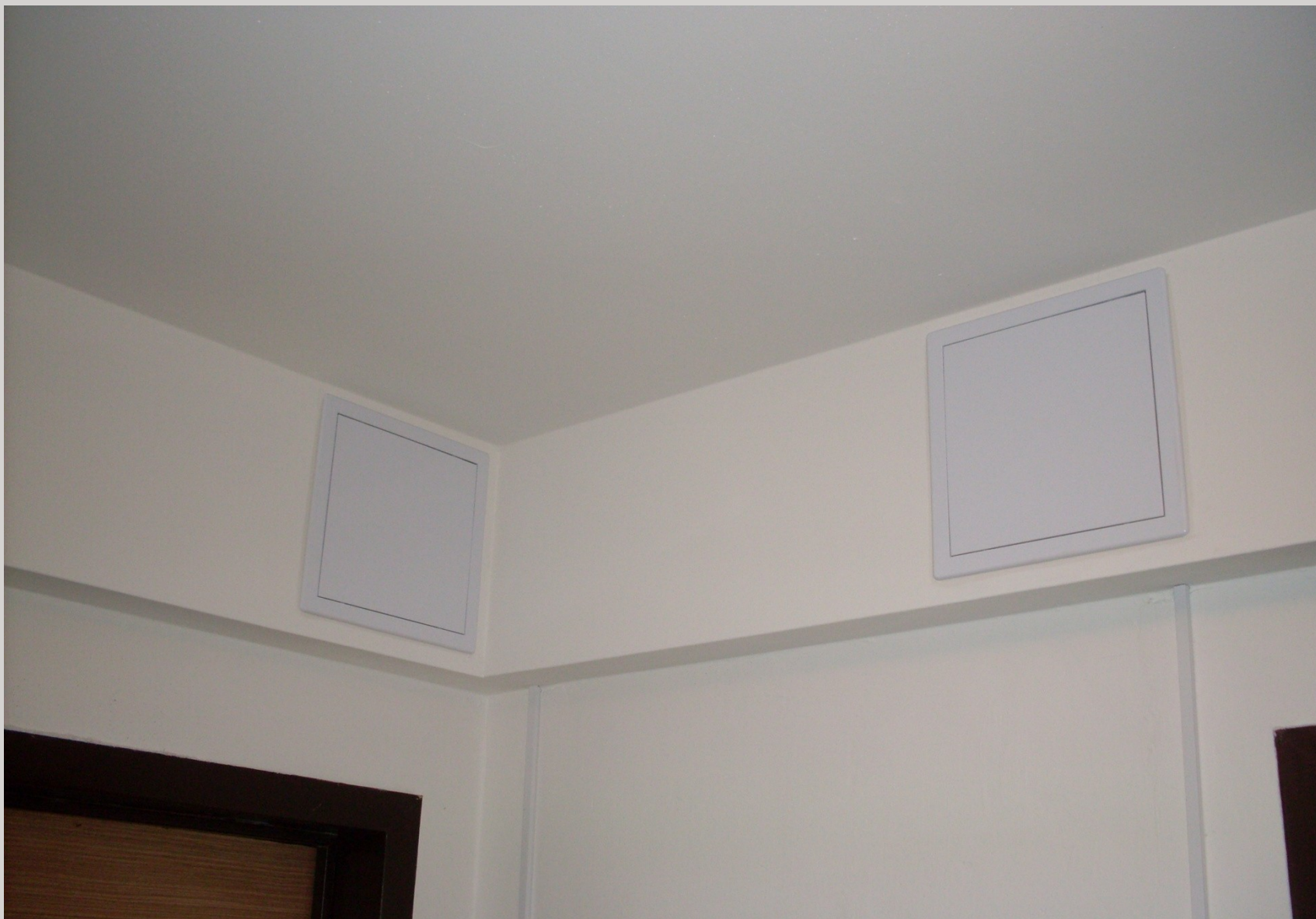
Interiér domu – montážní otvory v sádrokartonových obkladech
