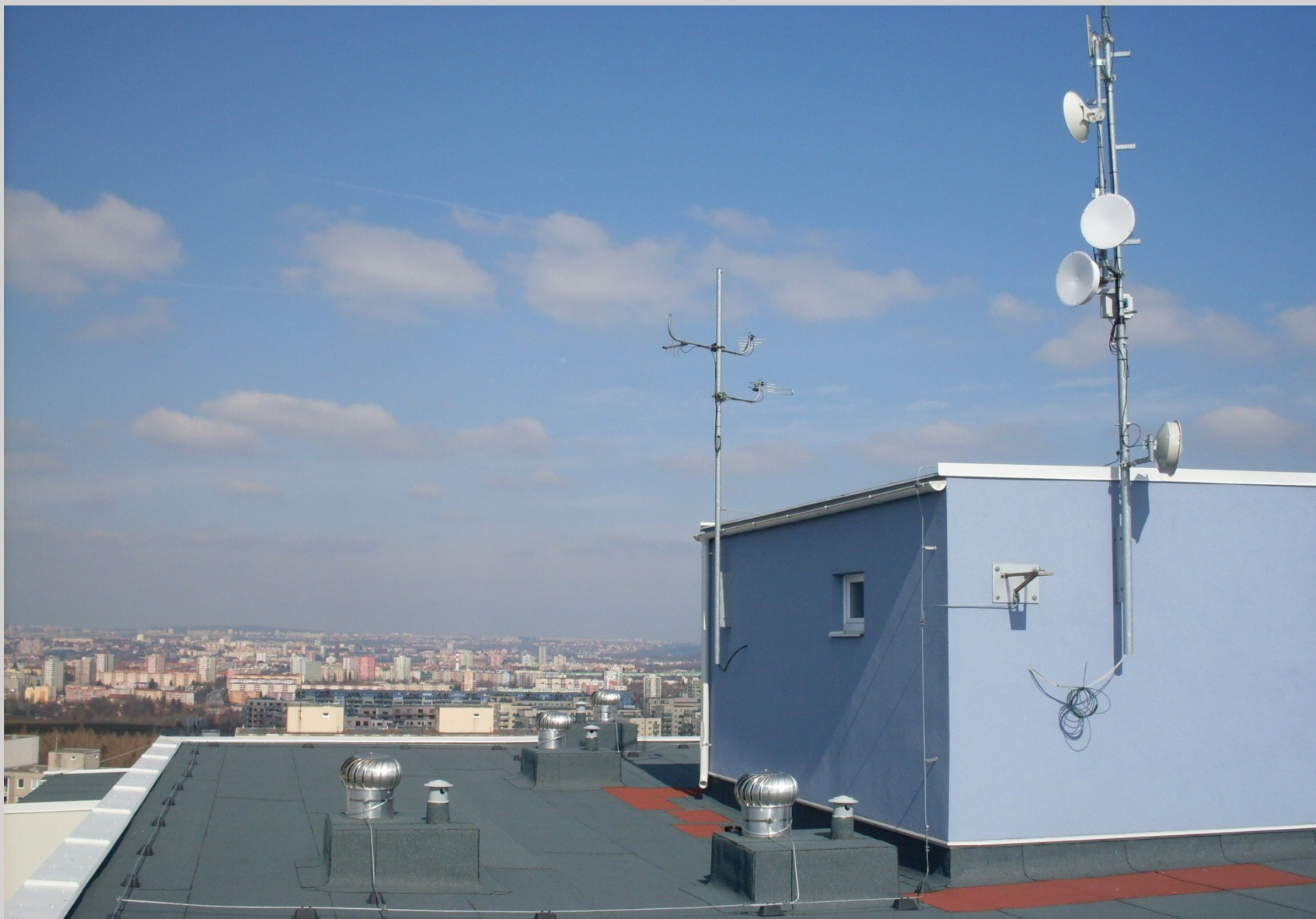
Střecha - nové stožáry na anténní systémy
