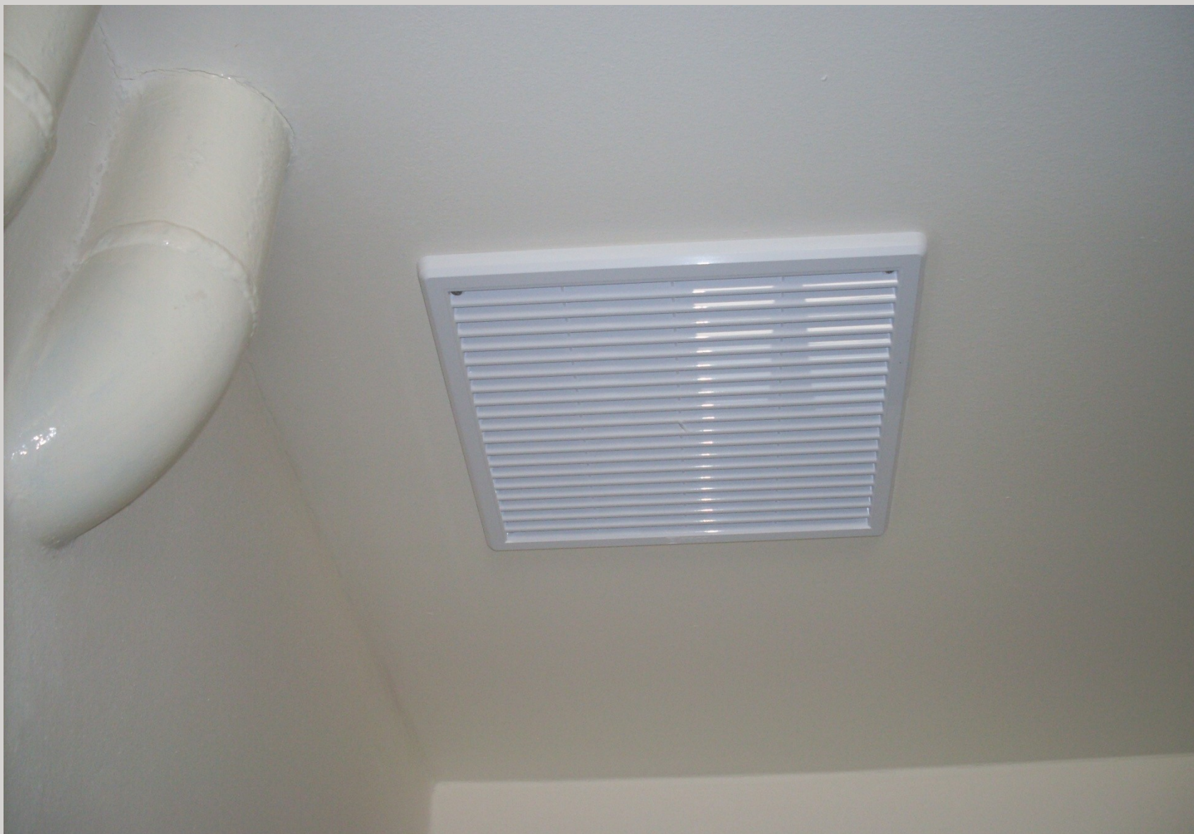
Interiér domu – vstupní prostor s přeložkami vedení
