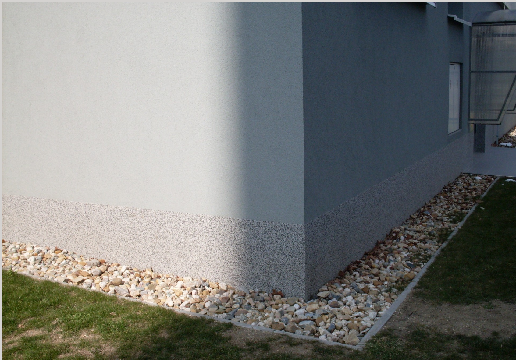
Sokl domu – hydroizolace a úprava okolí domu
