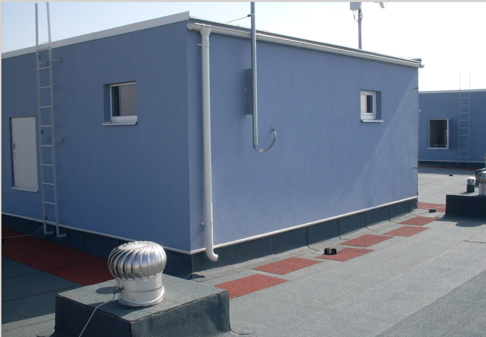
Střecha - pochozí chodníčky a nové okapy
