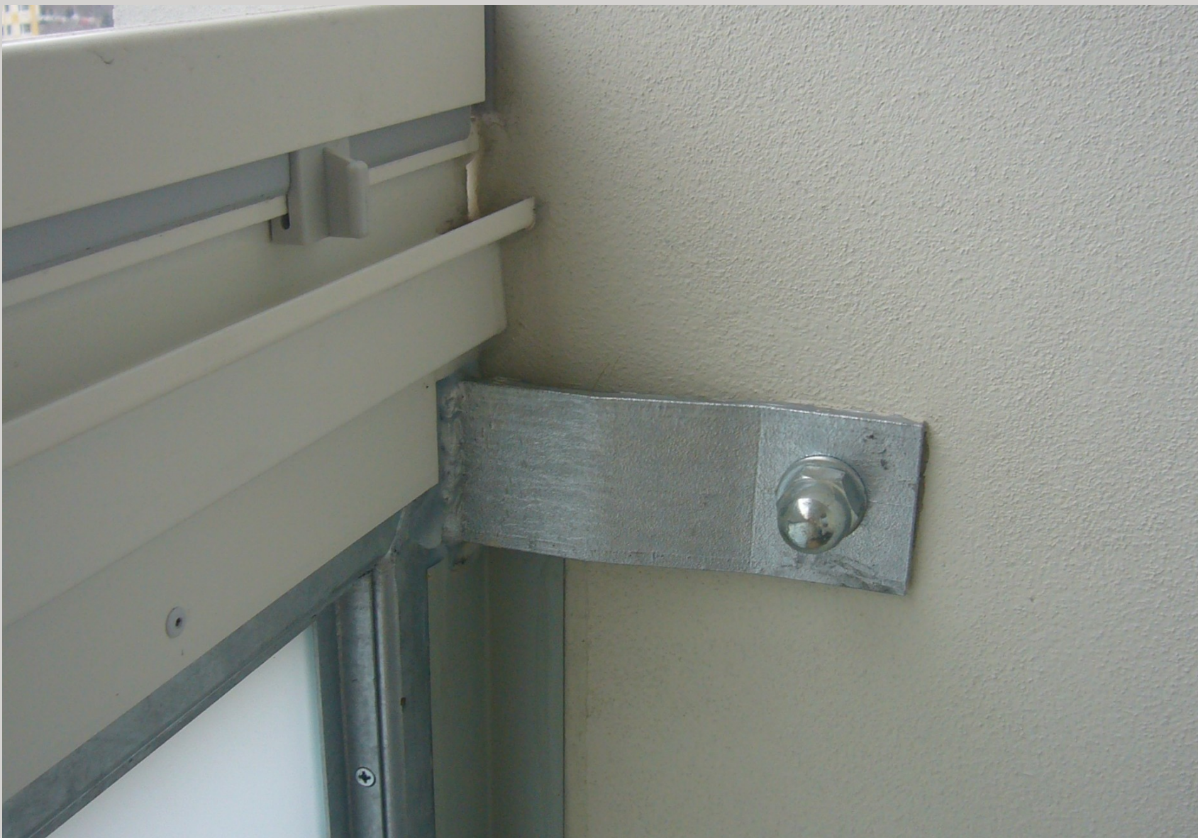
Lodžie – uchycení protikorozně ošetřeného zábradlí
