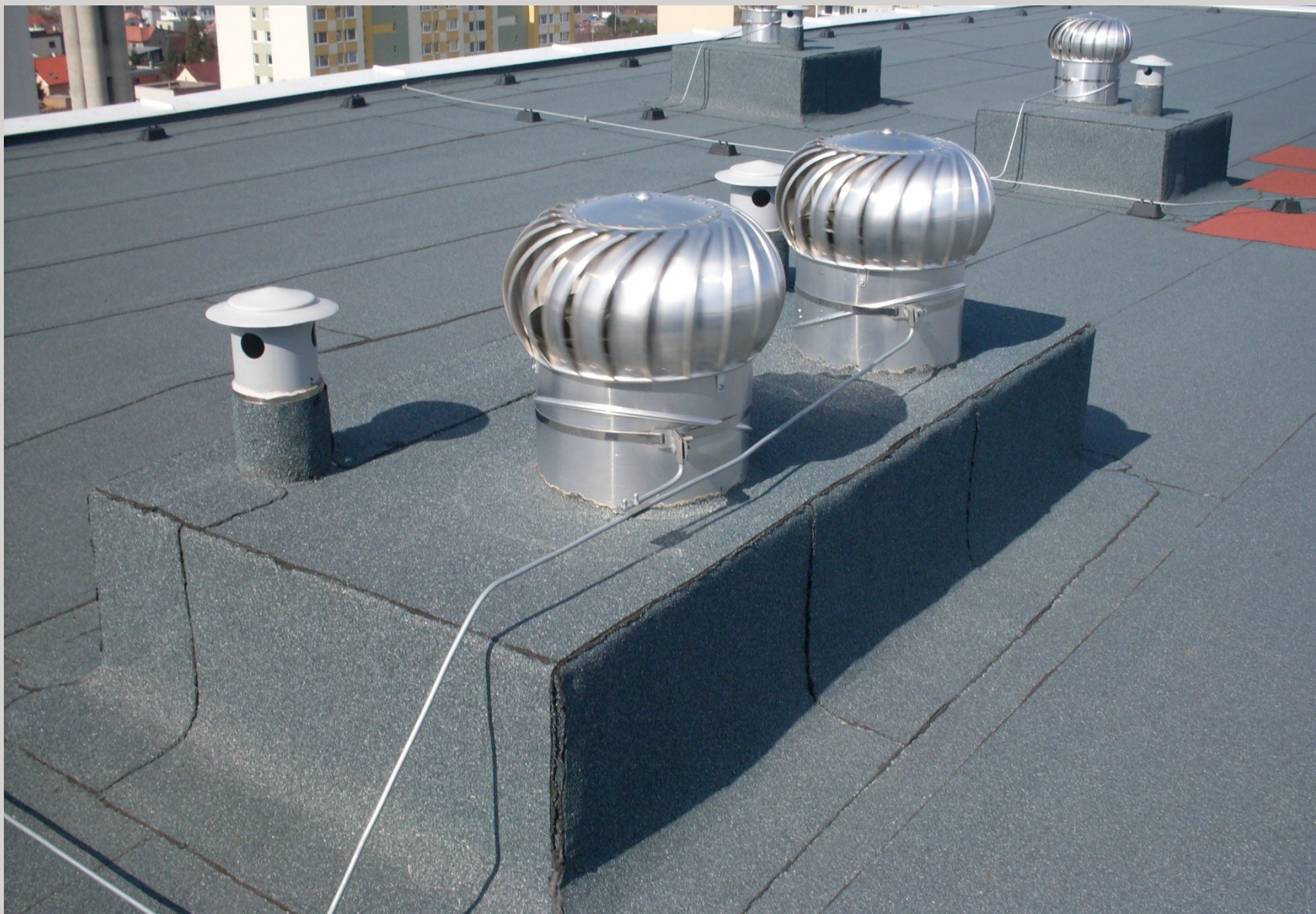
Střecha – nová izolace a střešní nadstavby svislých vedení
